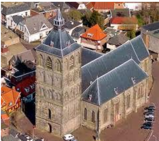
1151-R Oldenzaal. Ook in Delden bouwactiviteiten.
